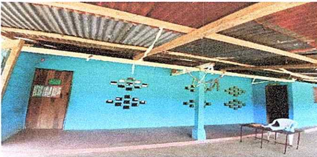
Foto 5: Se construira dos servicios sanitarios y sus accesorios.
